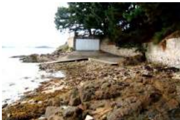
Figure 43 : Roche médiolittorale en mode abrité, largement artificialisée dans le secteur de Toulindac / port-Blanc à Baden, L. Picard, ONCFS
