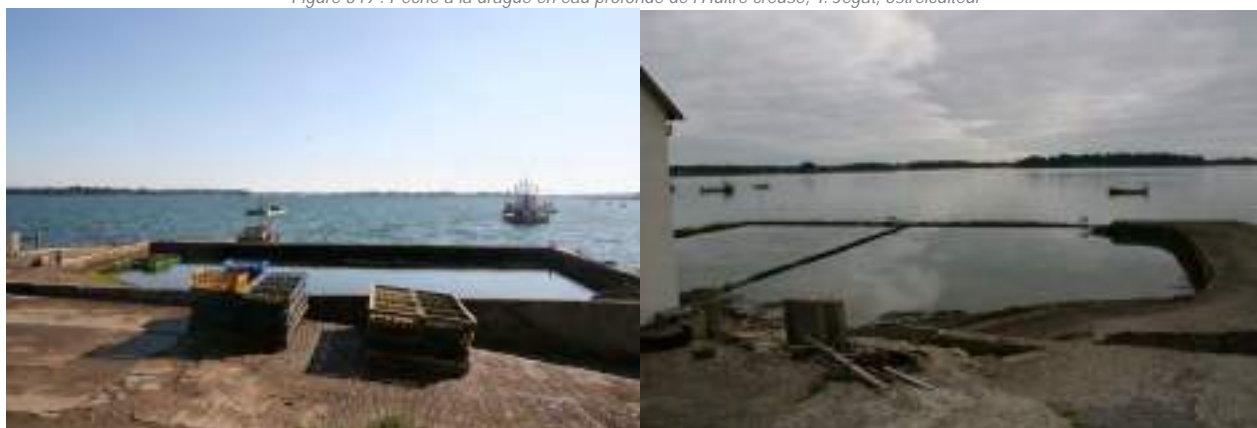
Figure 350 : Bassin inmersible et submersible de chantier ostréicole, R. Pasco, SIAGM
