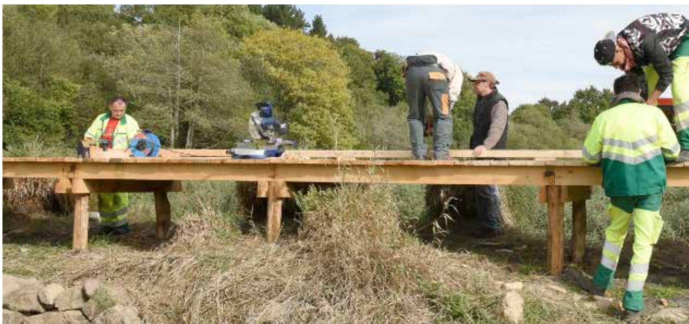
Chantier « Nature et Patrimoine » © AQTA
