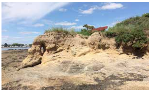
Banc à proximité immédiate d'une zone d'érosion.
