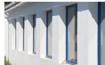
peinture sur enduit ciment
