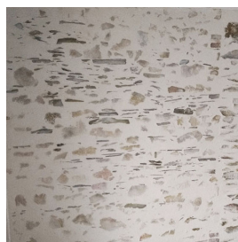
jointoiment pierre vue au chaux - sable
