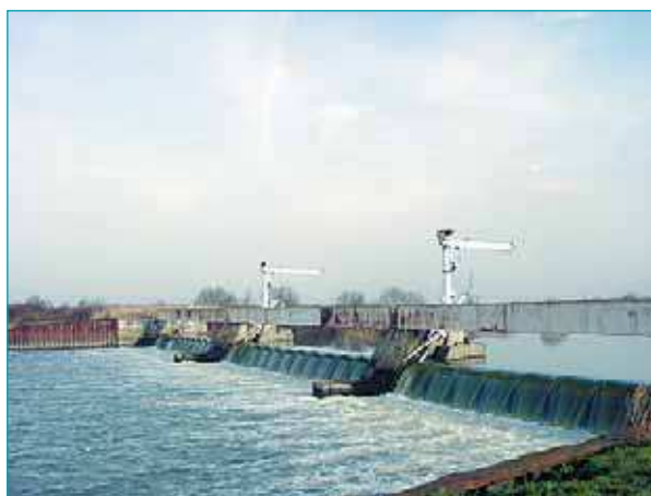
Barrage de Pagny sur la Saône à grand gabarit.
