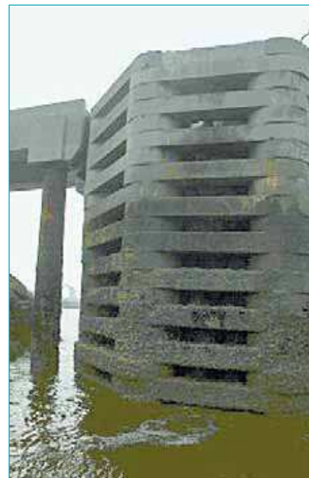
Groupe des ouvrages de protection : musoir de digue.
