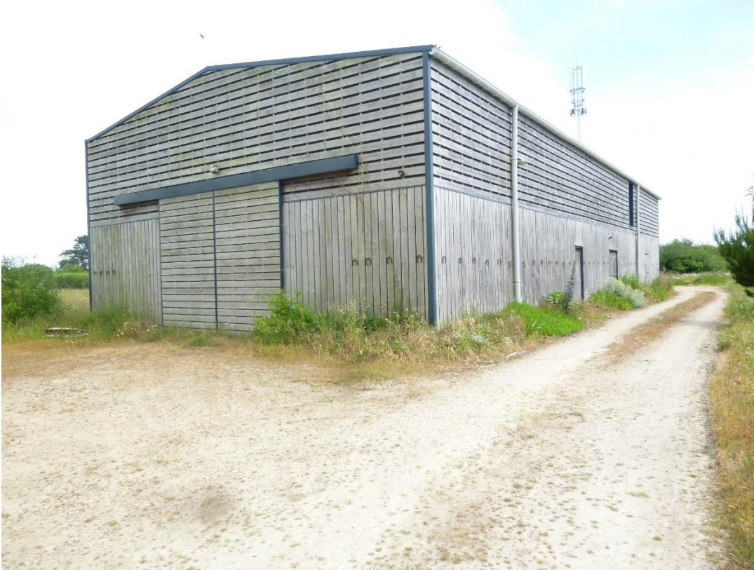
Entrée coté route
