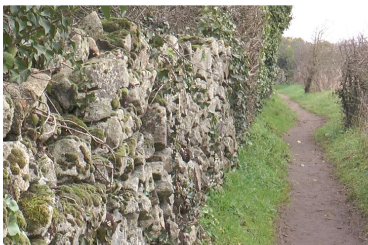
Figure 8 : Mur de soutènement à léger fruit à Saint-Armel. Crédit PNRGM (2022)
