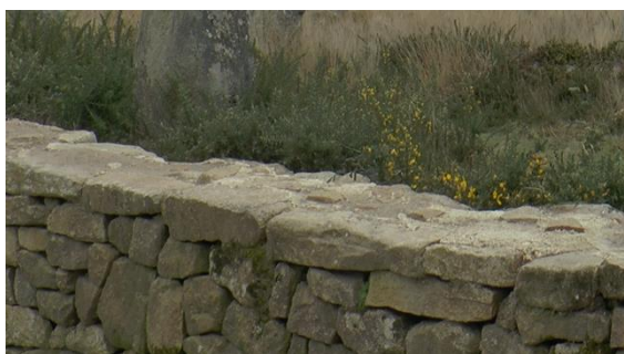
Figure 13 : Couronnement scellé au lait de chaux. Crédit : PNRGM (2022)
