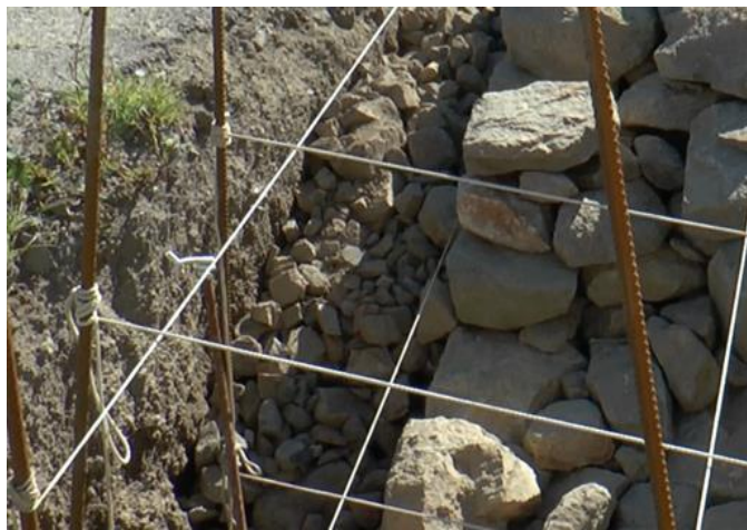
Figure 11 : Drain aménagé entre le front de terrassement et le parement du mur, Sénégal
