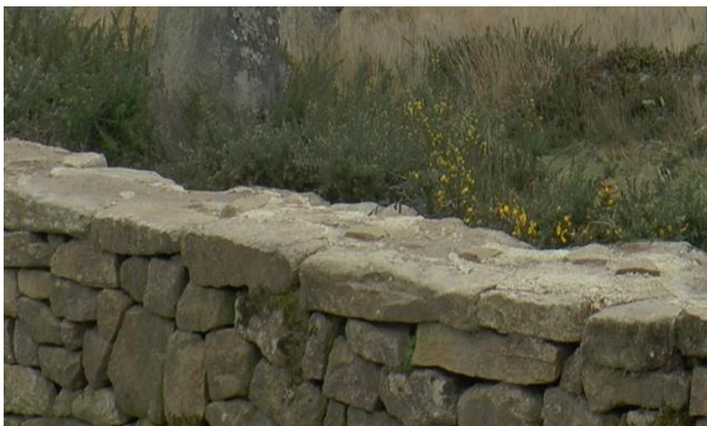
Figure 30 : Couronnement scellé au lait de chaux. Crédit : PNRGM (2022)
