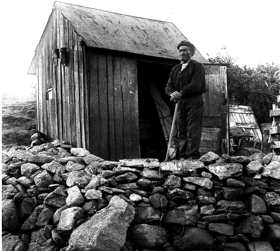
Figure 29 : Un terre-plein de pierre sèche dans une exploitation ostréicole du Golfe fin XIXème-début XXème siècles. Crédit : Gilles Millot et Pierre-Yves Dagault, Golfe du Morbihan : Album des gens de mer, coll. particulière
