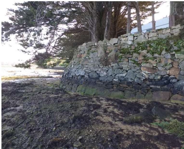
Figure 16 : Mur de protection et de soutènement, Sarzeau. Crédit : PNRGM (2022)
