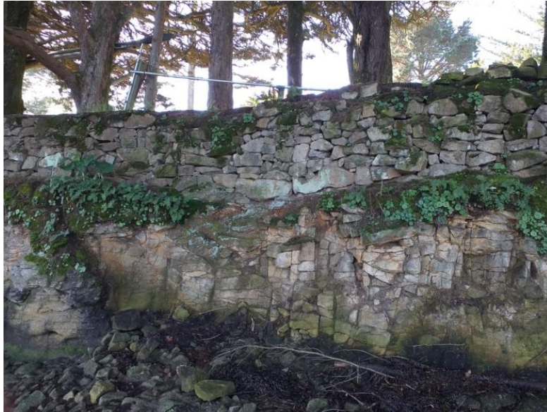
Figure 15 : Mur s'appuyant directement sur la roche mère, Sarzeau.
