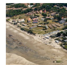
Désamiantage et démolition des bâtiments de première ligne (plages sud de Soulac-sur-Mer)
