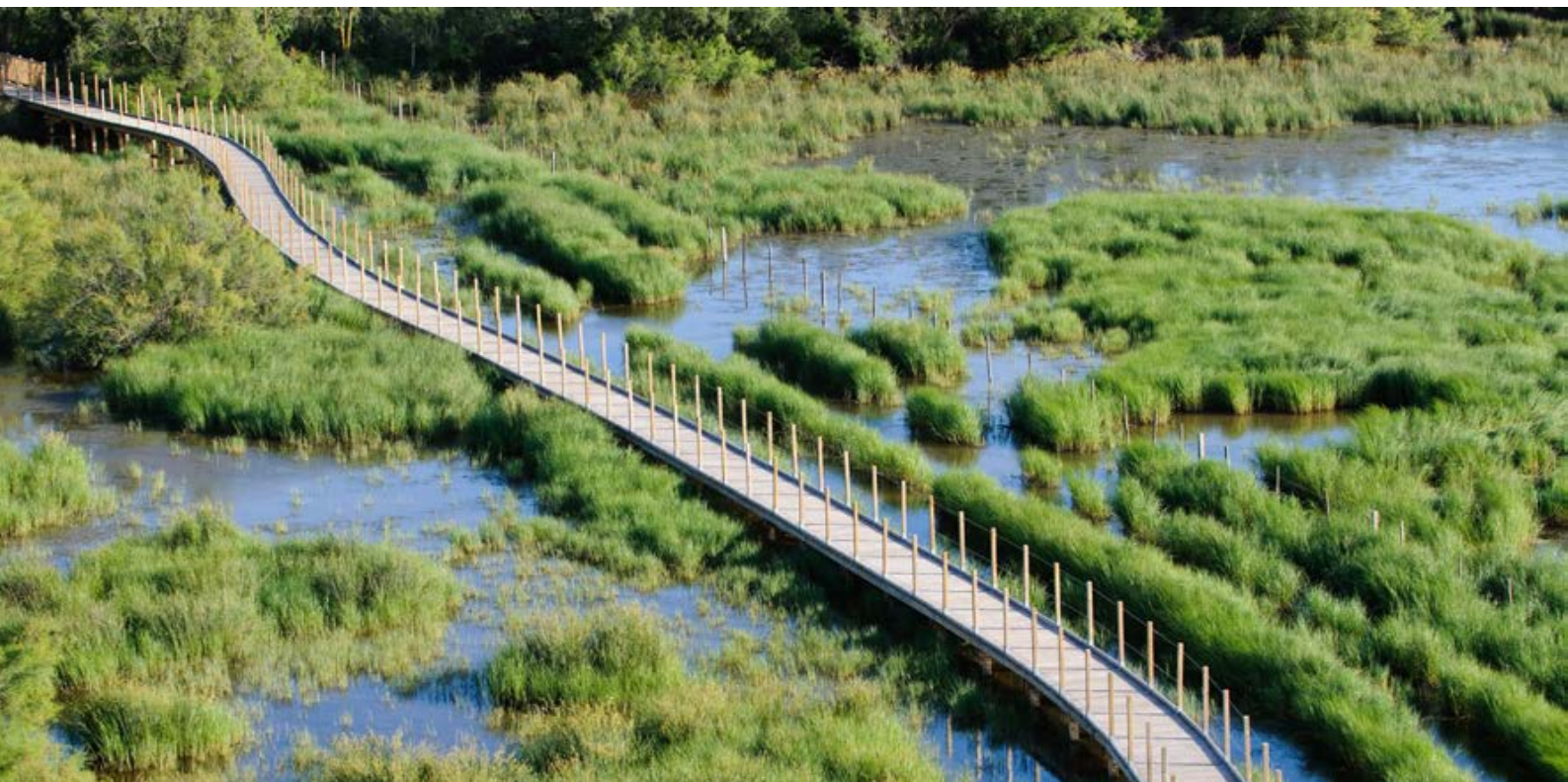
Cheminement en bois dans la Camargue Gardoise © Arnaud Bouissou-Terra
