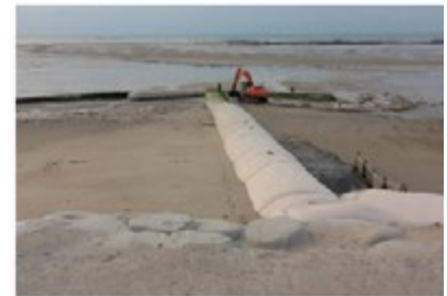
Epi en géotextile à Gouville-sur-Mer (06/12/17) © Thierry Houyel
