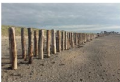
Pieux hydrauliques à Agon-Coutainville (11/10/17) © Coutances mer et bocage
