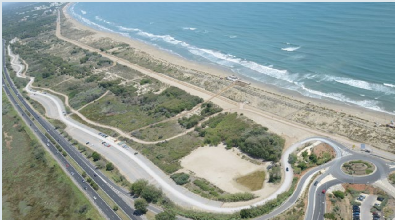
Vue aérienne du site après travaux mais avant cicatrisation végétale. L'emprise de l'ex-RD est encore très visible Photo © Communauté d'agglomération du Pays de l'Or
