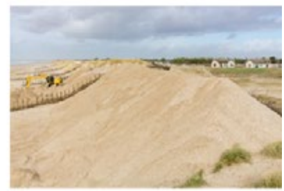
Rechargement en sable à Pirou (07/02/17) © Thierry Houyel
