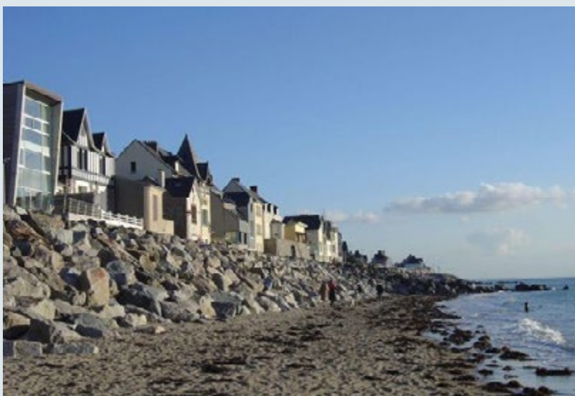
Front de mer de Coutainville avec enrochements longitudinaux, et demain ? Photo © OT Coutainville
