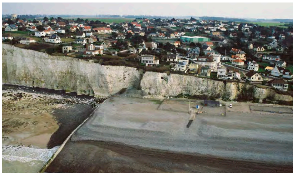
Figure C14 – Impact d’un épi entraînant d’un côté une accumulation limitant l’action marine au pied des falaises et de l’autre l’accentuant
