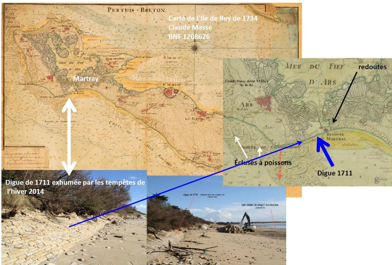
Des digues et de leur résilience : la digue du Martray (Ile de Ré) 1711-2014
