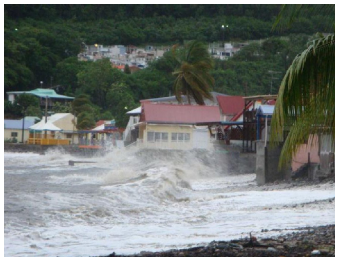
Les ravages du cyclone Hugo sur le quartier littoral de Ferry © CANBT
