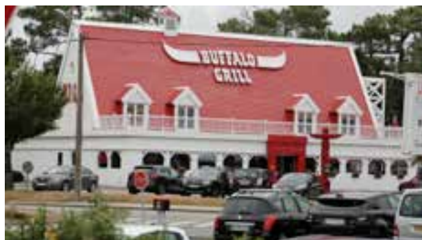
Exemple d'enseignes sur toiture
