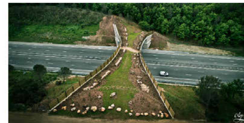
Ecopont de Brignolle, financé par la société Escota au titre du paquet vert autoroutier. Ce type d'ouvrage peut servir aux animaux mais aussi aux randonneurs de traverser les grandes infrastructures routières.
