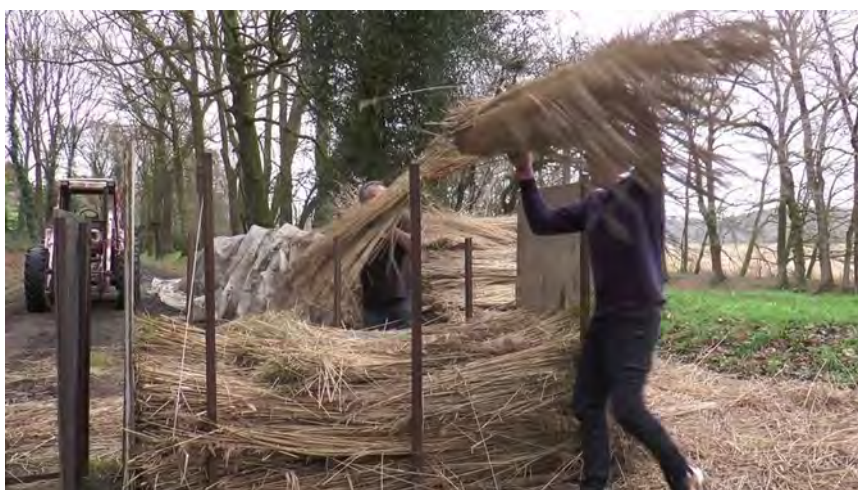
III. 3. Disposition des gerbes de roseau en quinconce dans la matrice rectangulaire. ©PNRGM. 2020
