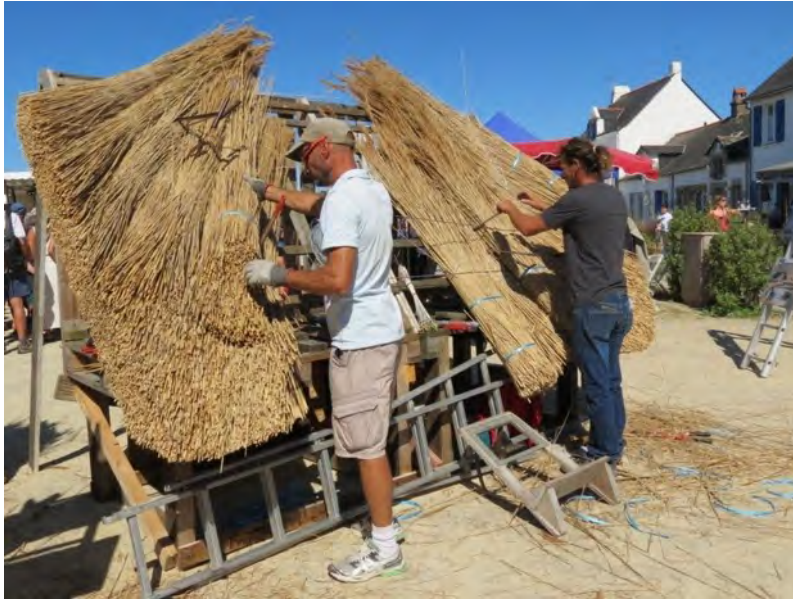
III. 8. Démonstration de la technique verticale (à gauche) et horizontale (à droite) lors de la fête du Parc de Brière. © PNR de Brière. 2019
