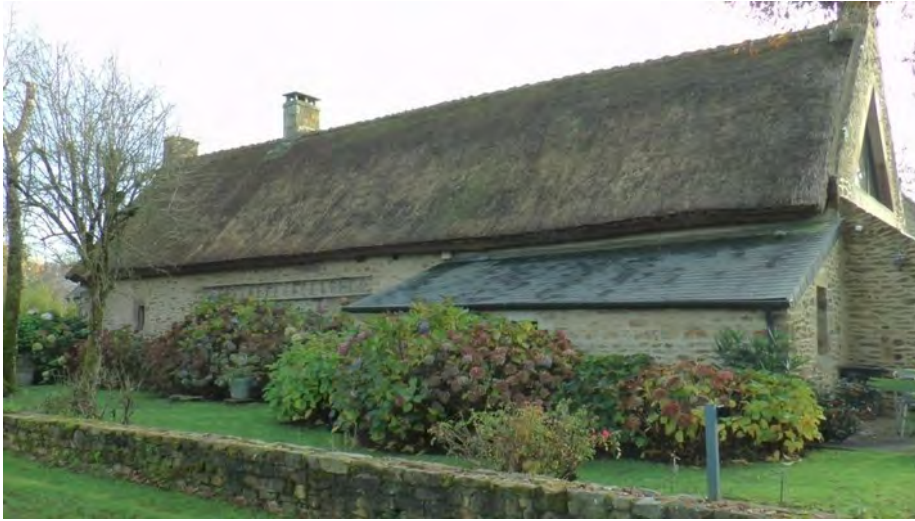
III. 39. Bodéno, Plougoumelen : échelle resserrée contre le mur arrière. ©PNRGM, 2020
