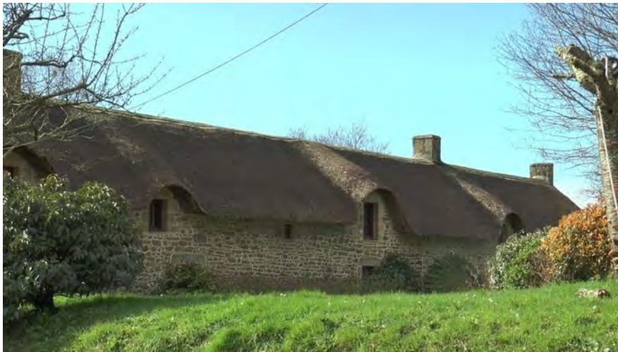
Ill. 28. Cahire, Plougoumelen : faîtage en ciment. ©PNRGM. 2020
