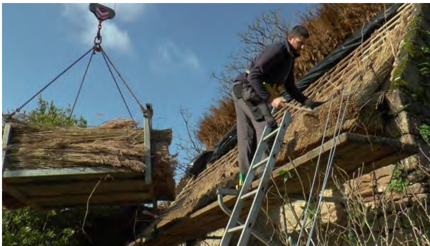
III. 16. Pose d'une botte. Dans la main du couvreur, la crémaillère qui la maintiendra en place. ©PNRGM. 2020
