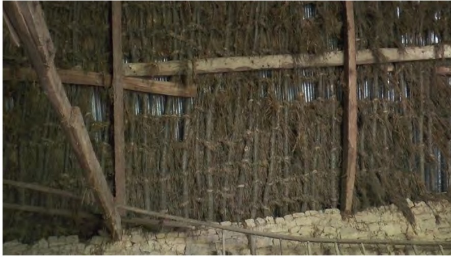
Ill. 40. Kerverec, Ploeren : charpente ancienne recouverte de tôle dans les années 1970. ©PNRGM. 2020
