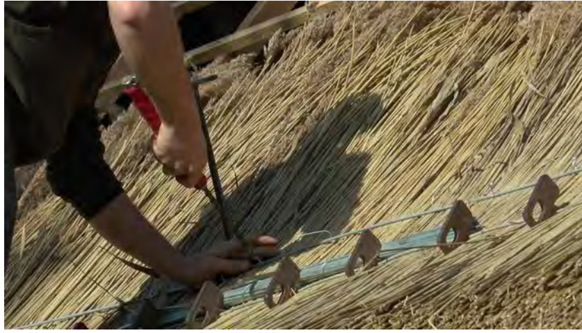
Ill. 25. Fixation des fils de ligature à l'aide d'un « tourniquet ». ©PNRGM. 2020
