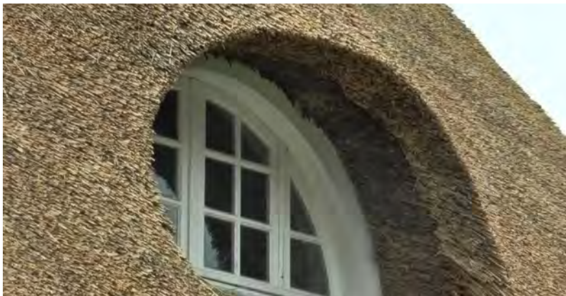
III. 9. Détail d'une lucarne : le chaume neuf, plus clair, se démarque nettement du chaume ancien, plus foncé. ©PNRGM. 2020
