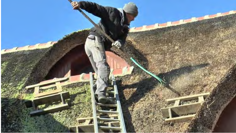
III. 31. Enlèvement des déchets (mousses, lichens, chaume altéré). ©PNRGM. 2020
