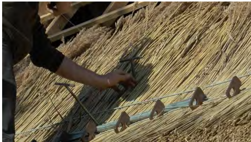
III. 23. Passage du fil de ligature dans la rainure de l'aiguille mâle. ©PNRGM. 2020
