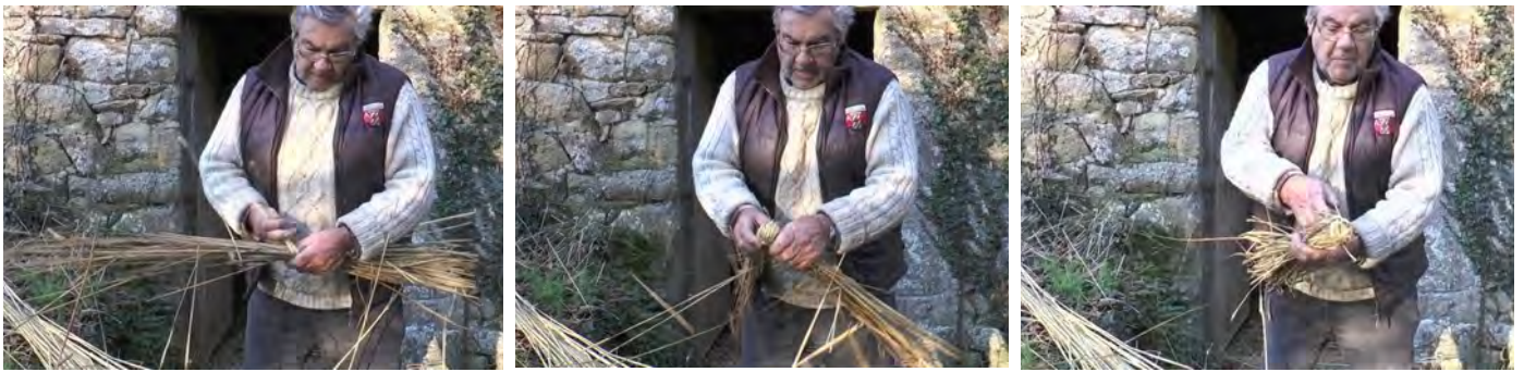
Ill. 33. Formation d'un « bouchon » de paille de seigle pour le repiquage. ©PNRGM. 2020
