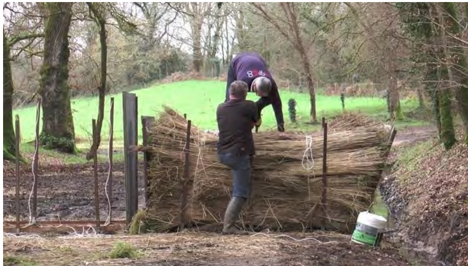
III. 4. Serrage et ligature du ballot. ©PNRGM. 2020
