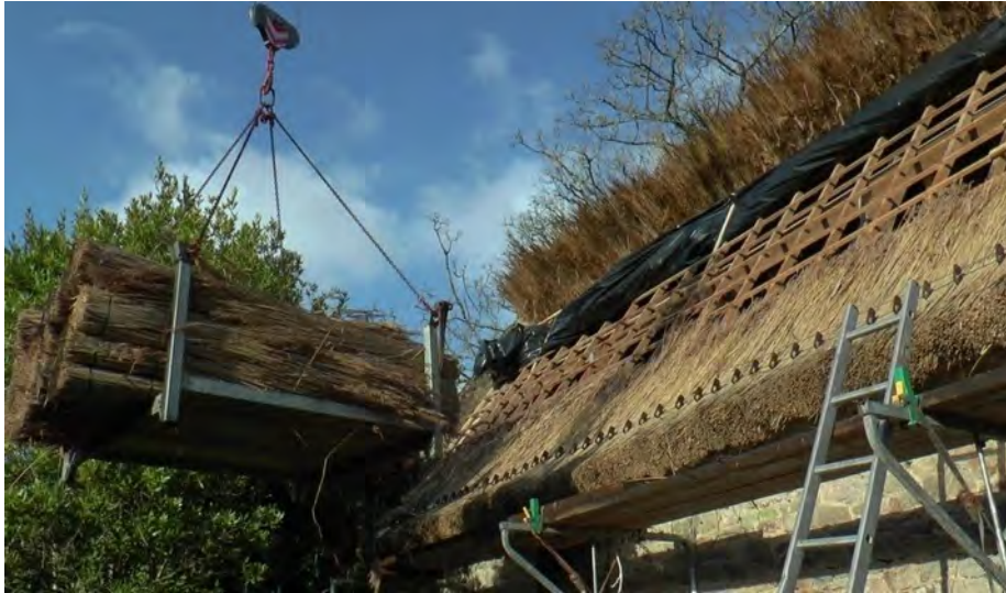
Ill. 13. Grue de levage et plateau de chargement. ©PNRGM. 2020
