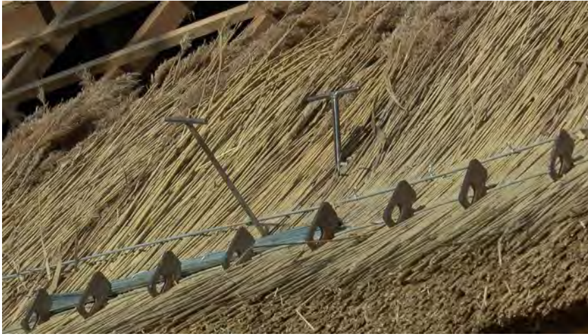
III. 15. Détail d'une couverture. De haut en bas : aiguilles ; barre de fixation définitive et fils de ligature vrillés ; crémaillères et barre de travail. ©PNRGM. 2020
