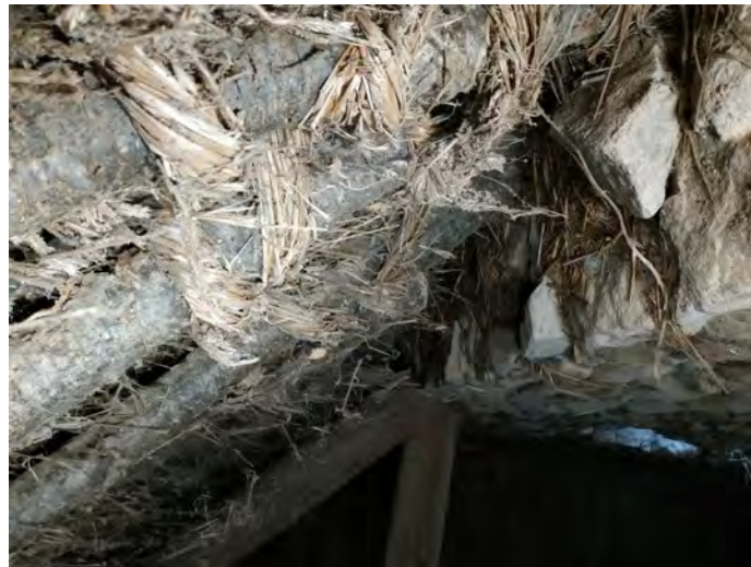
Ill. 41. Kerverec, Ploeren : détail de la charpente. ©PNRGM. 2020
