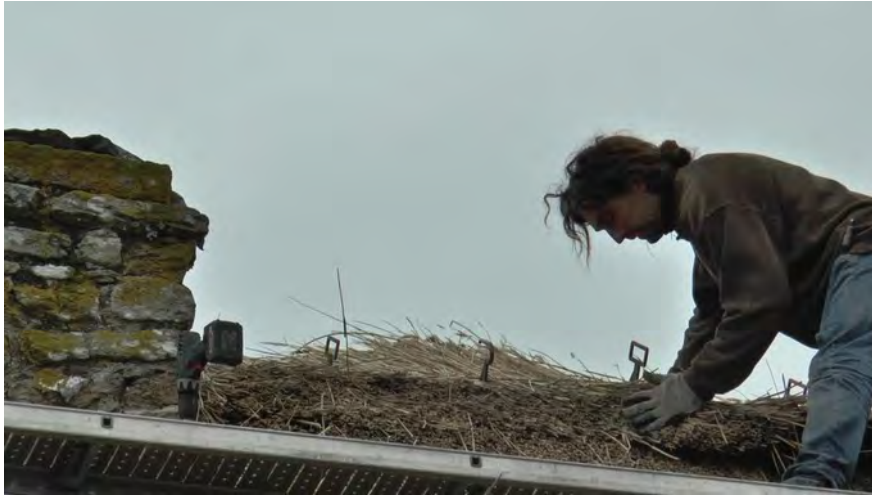
III. 18. Cassage des bottes et premier façonnage à la main pour mettre le roseau dans la pente. ©PNRGM. 2020
