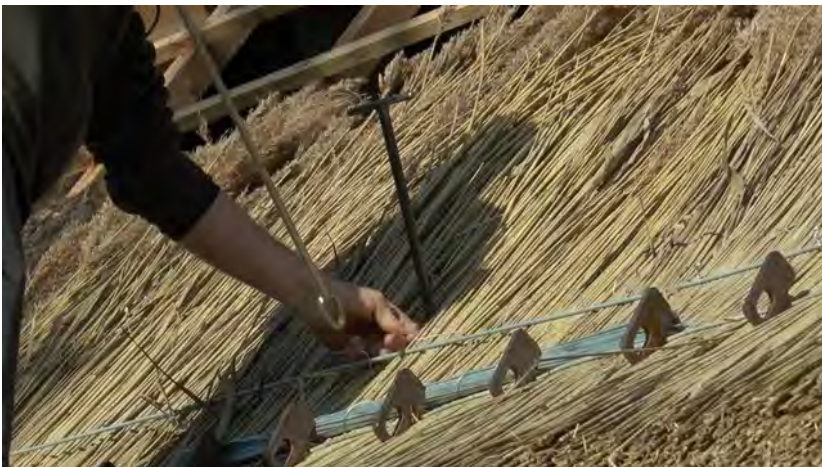
III. 24. Récupération du fil de ligature passé derrière le liteau par l'œillet de l'aiguille femelle. ©PNRGM. 2020
