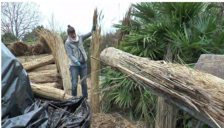
Ill. 7. Bottes de roseau prêtes à être posées en couverture. ©PNRGM. 2020
