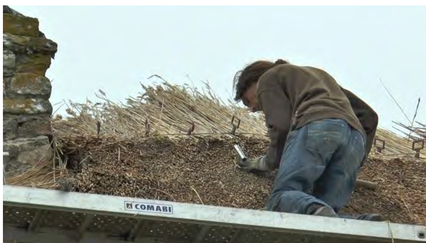
III. 12. Contrôle de l'épaisseur du chaume à l'aide d'une aiguille graduée. ©PNRGM. 2020
