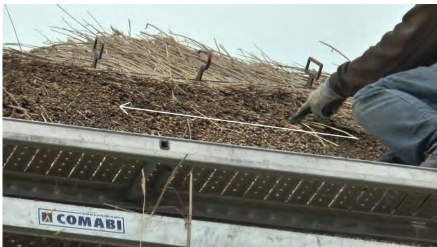
III. 19. Ligne de démarcation entre deux rangs de roseau (flèche blanche). ©PNRGM. 2020
