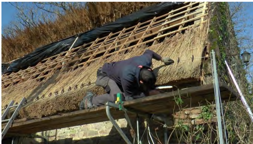
III. 11. Façonnage du larmier à l'aide d'une palette. ©PNRGM. 2020
