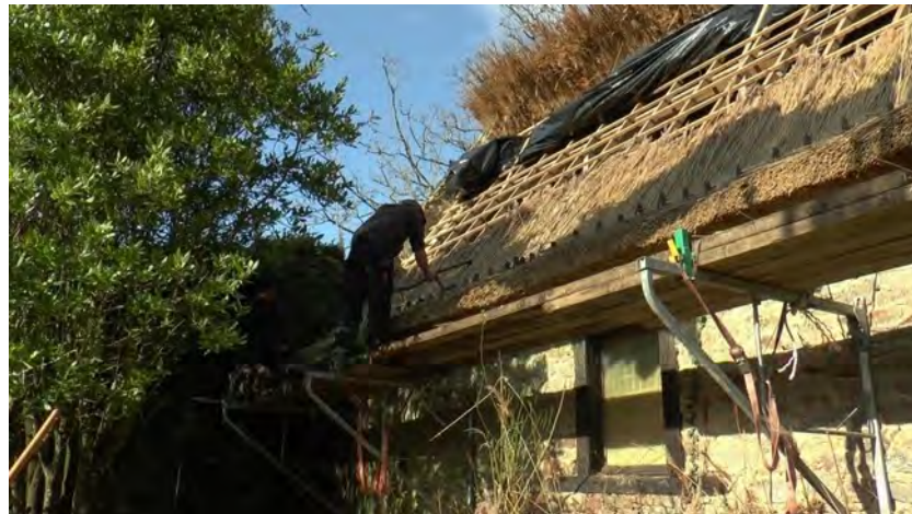
Ill. 26. Serrage de la barre de fixation à l'aide d'un levier. ©PNRGM. 2020
