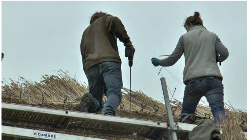
III. 22. Fils de ligature vissés sur les liteaux au niveau du faîtage. ©PNRGM. 2020
