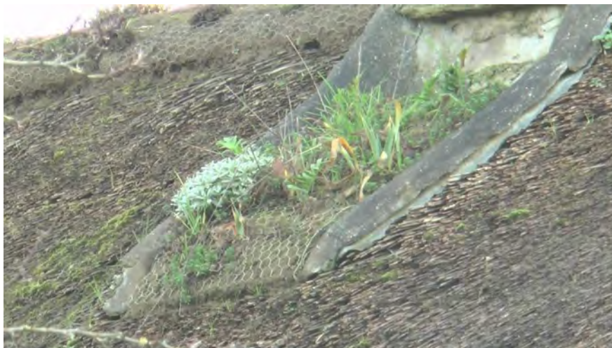
Ill. 30. Bodéno, Plougoumelen : détail d'une souche de cheminé. ©PNRGM. 2020
