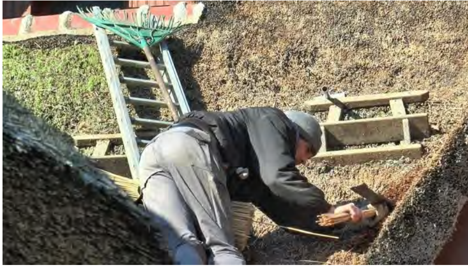
Ill. 32. Remaniage : réinjection de roseau dans les zones fragilisées. ©PNRGM. 2020
