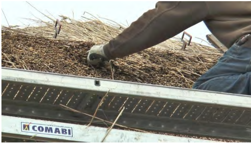
Ill. 20. Tirage du roseau pour le remettre en forme avec la palette. ©PNRGM. 2020
