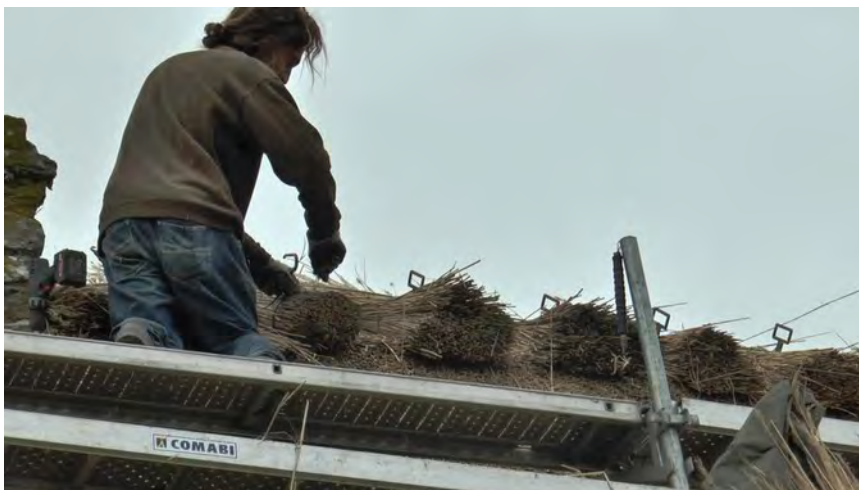
III. 17. Découpe du lien cerclant la botte avec un couteau. ©PNRGM. 2020
