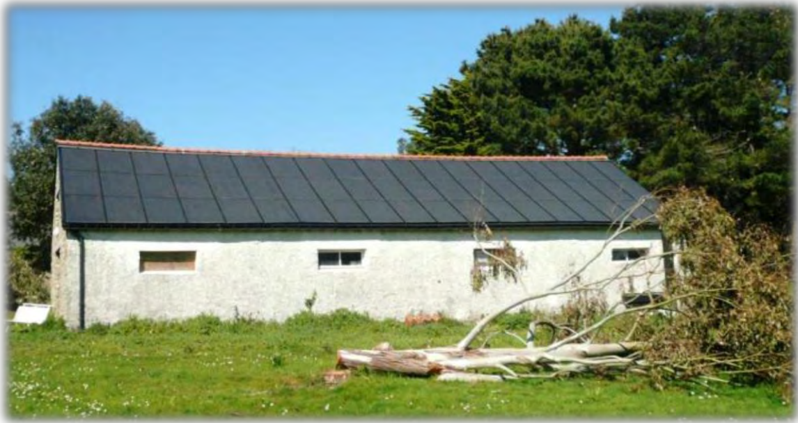
FIGURE 30 : LOCAL TECHNIQUE (EXTERIEUR) (PNRGM, 2014)
